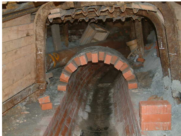
Budování přeložky zděné kanalizační stoky u OC Eden Vršovice (foto: David Kunnsberger)
