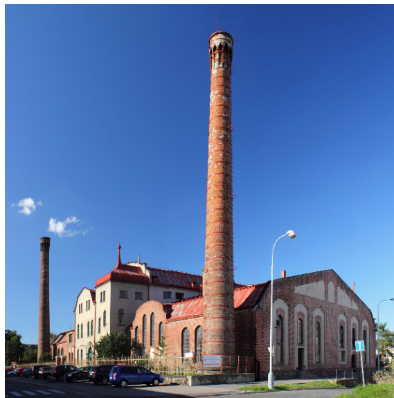
Objekt staré čistírny odpadních vod Praha - dnes Ekotechnické muzeum (foto: Milošlav Rejha / Wikimedia Commons)
